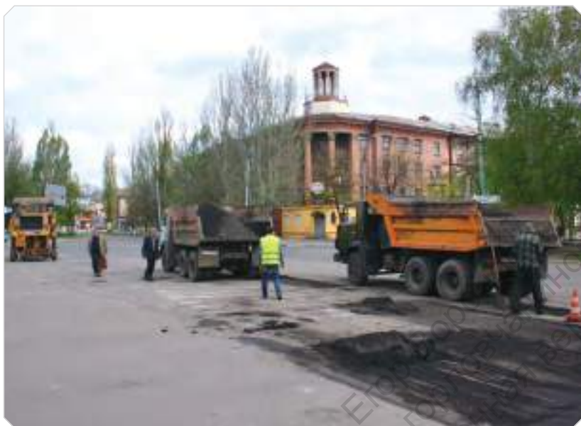
Ремонт дороги возле площади Победы, 22 апреля 2016 года
