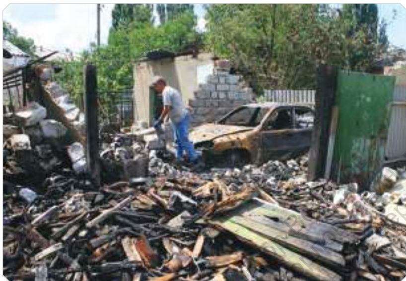
Последствия обстрела Никитовского района Горловки, 10 июля 2016 года
