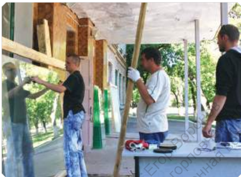
Работы по восстановлению ОШ № 85, 23 августа 2015 года
